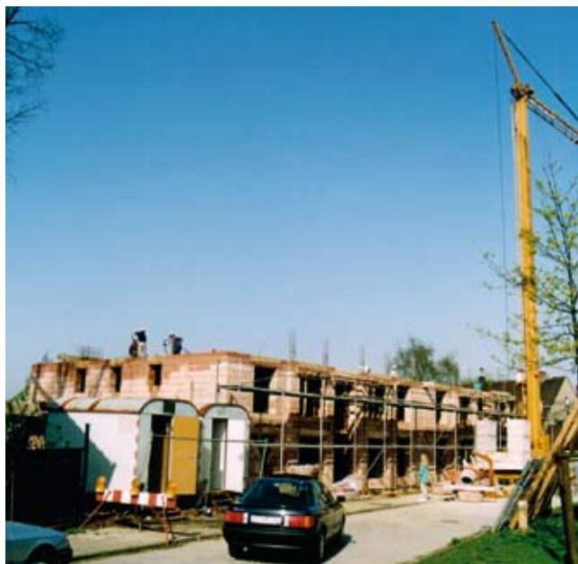
Foto oben: Baustelle Feldstraße
