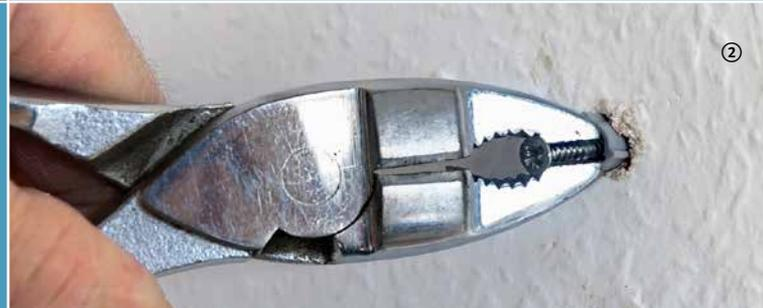
cherweise aus Nylon gefertigt, da haftet keine Spachtelmasse dran. Reinschlagen ist zumeist keine Option. Der Dübel ist am Ende gespreizt und verkantet sich schnell beim Reinschlagen. Zudem ist oft das Bohrloch nicht mehr tief genug, da sich Stein- und Mörtelreste beim Setzen hinter den Dübel geschoben haben.
