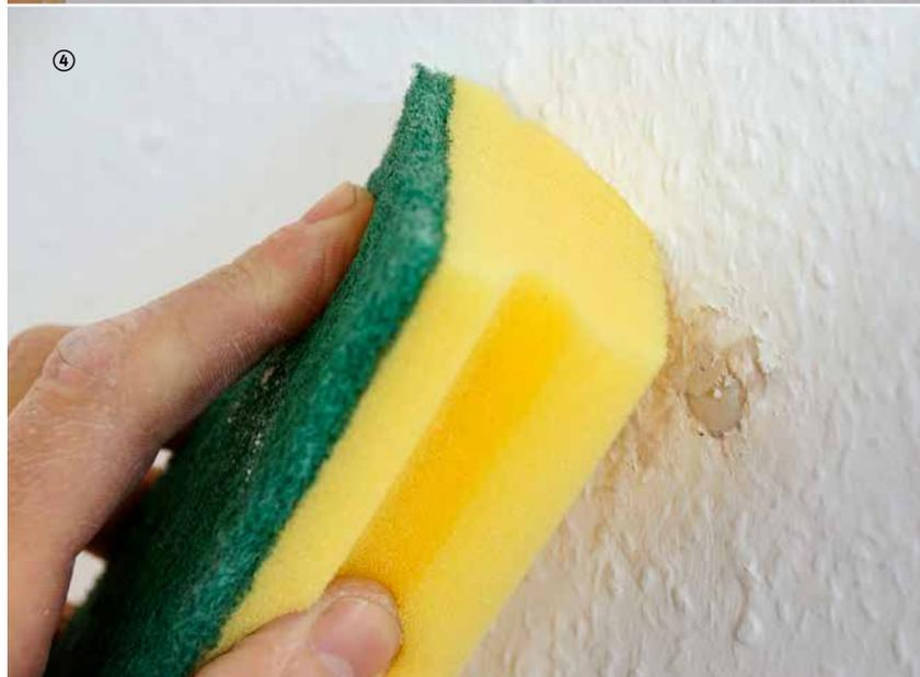
das Dübelloch. Perfekt ist es, wenn man die Masse im Dübelloch nicht weiter verdichten kann und etwas von der Masse aus dem Loch vorquillt. Dann kann man mit dem Spachtel die Masse mit der Wand plan abziehen.
