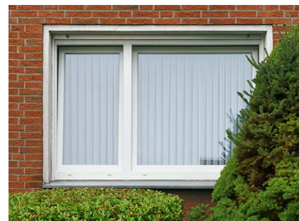
Fenster und Haustür in der Gartenstraße
