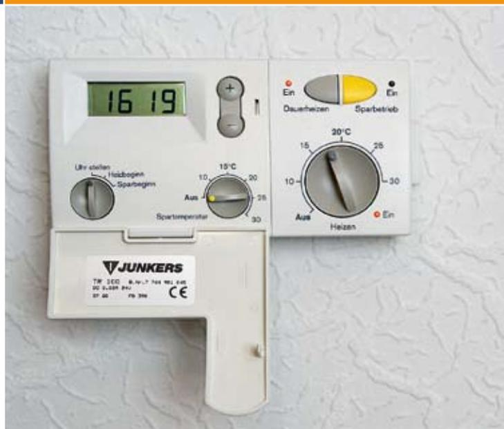
Am Raumthermostat wird im jeweiligen Zimmer die angestrebte Temperatur eingestellt. Bei Fragen zur Einstellung bitte bei der hwg melden.
